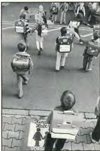
Schulwegmarkierung in Erlangen: Hier sind die Leitlinien und Wartekästen mit wetterfester Folie auf die Gehsteige geklebt.
