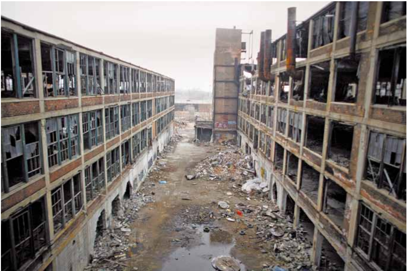
Die ehemalige Fertigungsanlage von Packard Motor Car in Detroit, Michigan. Eine Region, die zum sogenannten „Rust Belt“ der USA zählt Foto: REUTERS/Fotograf: Eric Thayer
