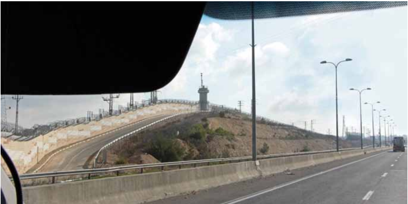
Sicherheitszaun an der Autobahn westlich von Jerusalem Foto: Gudrun Rapke
