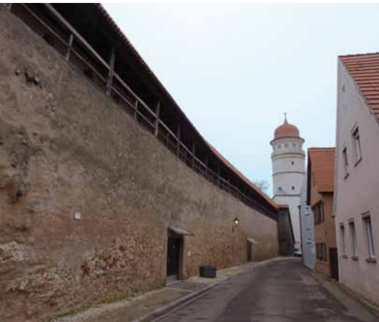
Wehgang der Nördlinger Stadtmauer zwischen Löpsinger Tor und Unterem Wasserturm Foto: Siegfried Münchenbach
