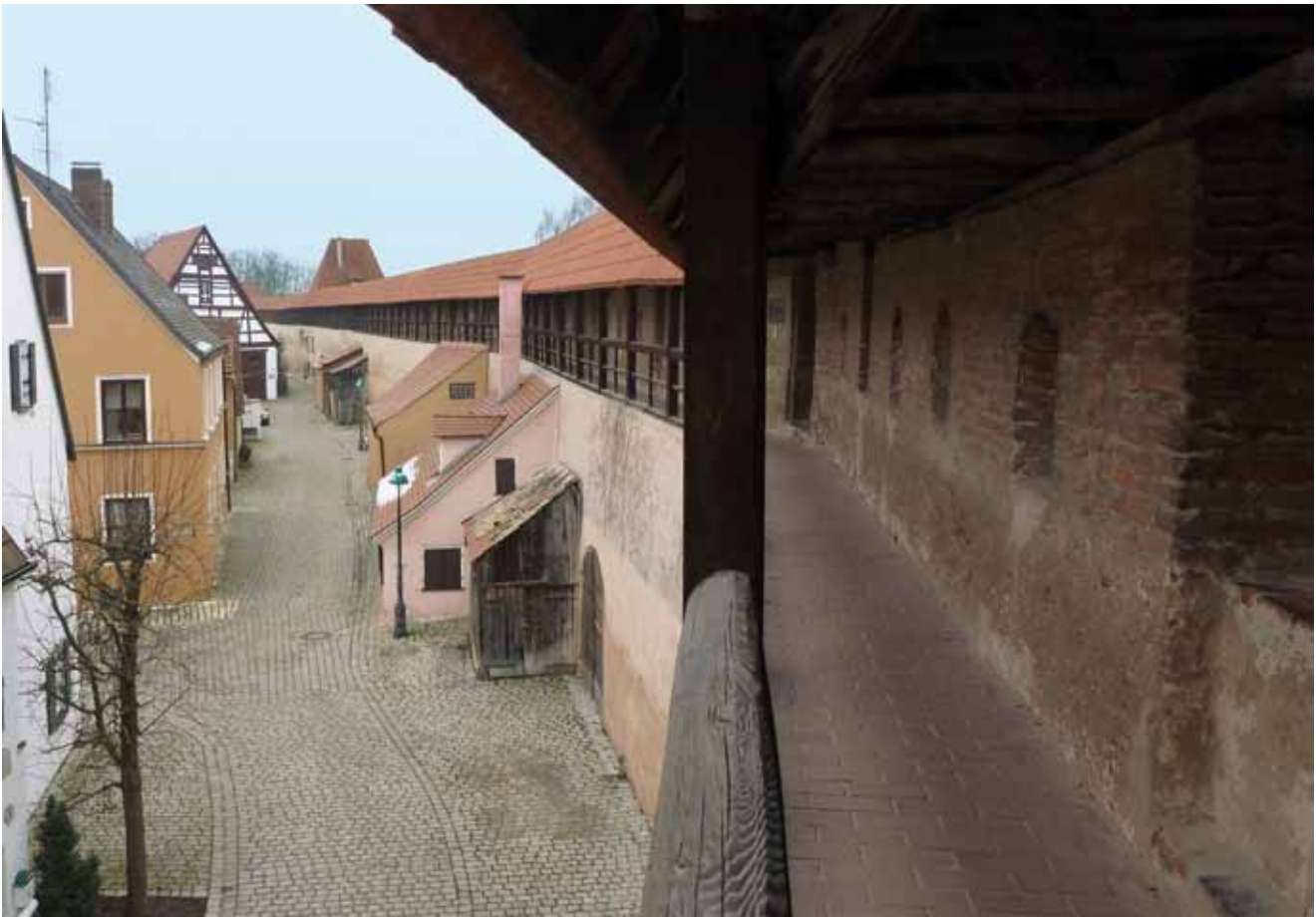
Stadtseitige Ansicht der Nördlinger Mauer am Deiningertor. Am Deiningertorturm wurden 1519 die oberen Stockwerke abgetragen und durch einen runden Aufbau ersetzt. Vom gotischen Turm mit quadratischem Grundriss sind die unteren Stockwerke erhalten. Foto: Siegfried Münchenbach
