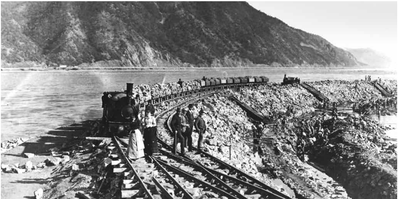
Baustelle des „Eisernen-Tor-Kanals“, der 1896 fertiggestellt wurde. Die Anlage dieses 1,7 km lange Kanals war die wichtigste Voraussetzung dafür, dass Tank-schiffe von Rumänien bis nach Regensburg verkehren konnten. Links des aufgeschütteten Dammes sieht man den mit Felsen durchsetzten, problematischsten Abschnitt des „eisernen Tores“, rechts davon den ausgesprengten Kanal.
